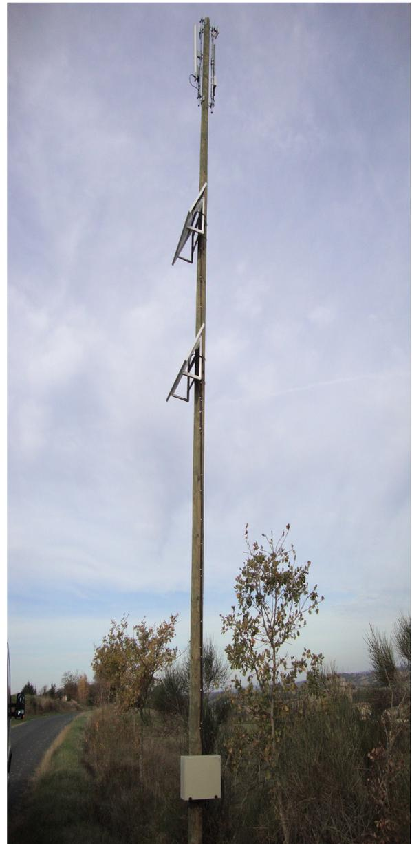
Antenne WiFi alimentée par des panneaux solaires
