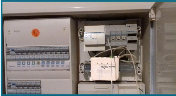
Ici, la GTL (gaine technique du logement) est matérialisée par un petit placard encastré dans lequel l'électricien installe les disjoncteurs d'électricité, le boîtier de test cuivre pour le téléphone et l'ADSL (DTI) et le DTIo (dispositif terminal intérieur optique) pour la fibre optique.
