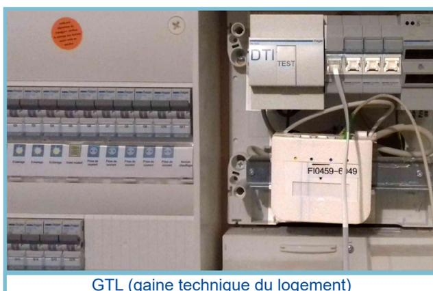
La GTL en photo ci-contre est matérialisée par un petit placard encastré dans lequel l'électricien installe les disjoncteurs d'électricité, le boîtier de test cuivre pour le téléphone et l'ADSL (DTI), le DTIO pour la fibre optique et les quatre prises RJ45 du câblage cuivre THD.
