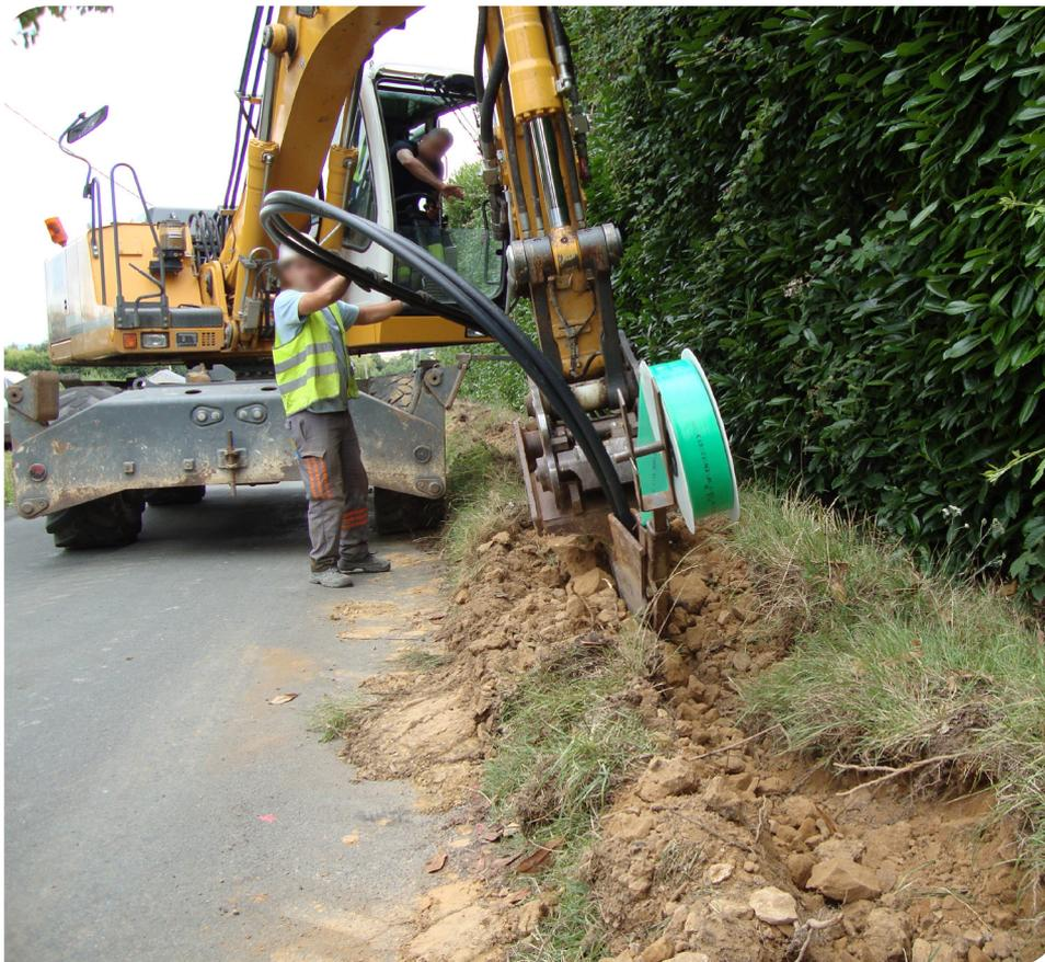
*Pose de fourreaux PEHD par la technique dite du soc vibrant
