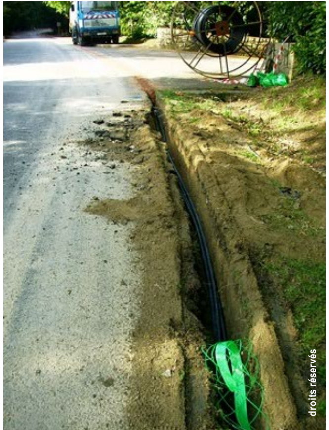
Tranchée, fourreaux et grillage avertisseur Pose en bordure d'une route bidirectionnelle
