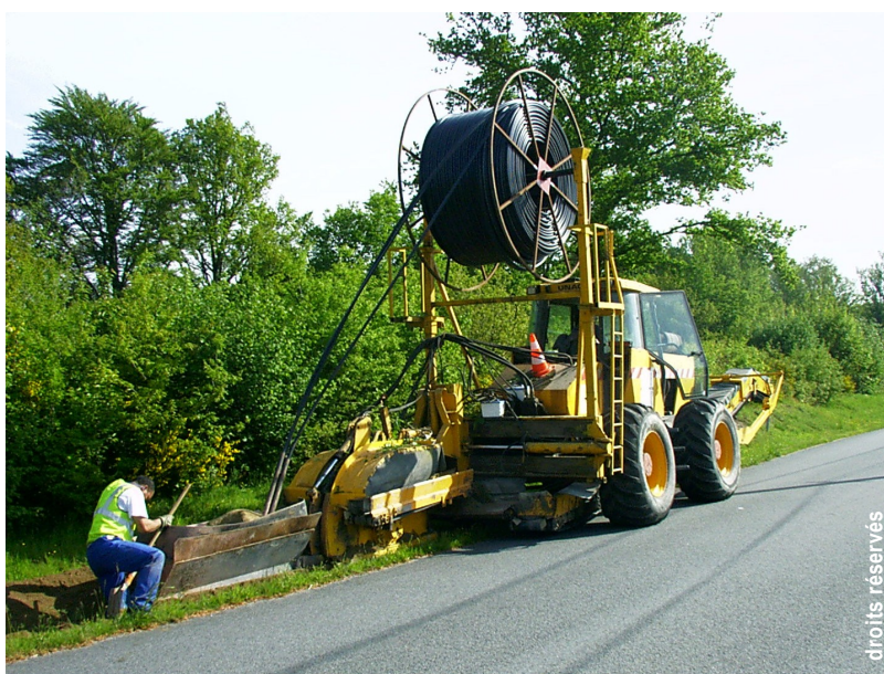
Pose de fourreau PEHD
