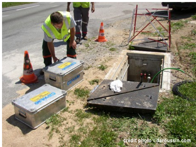
Intervention sur les câbles au niveau d'une chambre
